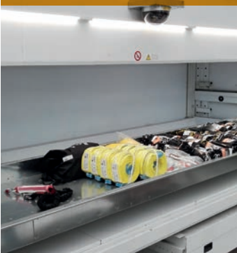
Iluminación LED bahía externa
