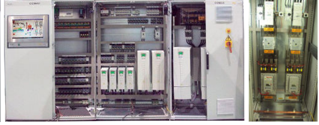
Armarios de control y potencia.
