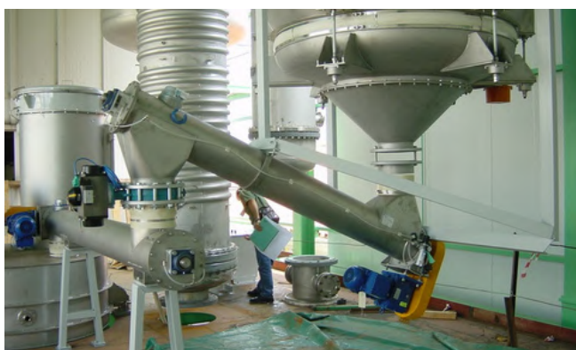
Sinfines transportadores de producto
