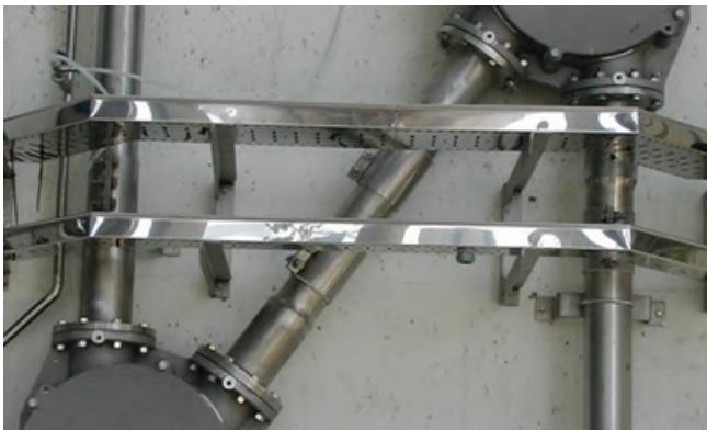
Válvulas desviadoras baja presión
