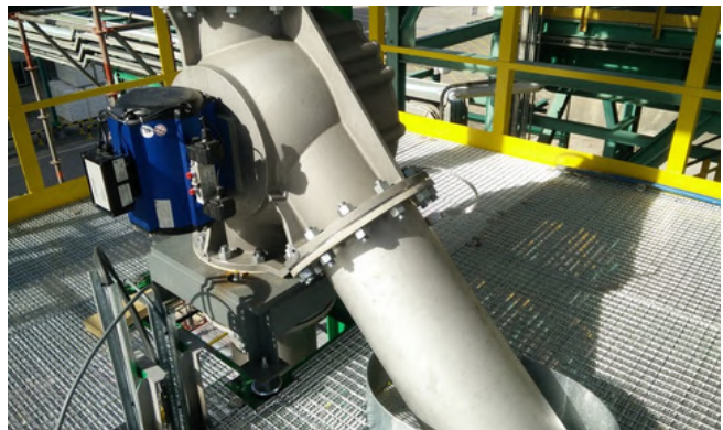
Válvula desviadora de alta presión
