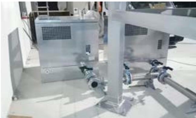
*Ejemplo de 2 compresores con válvulas by-pass*
