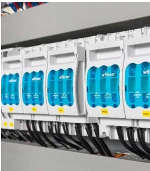
Nuestra política es diseñar cada panel teniendo en cuenta **las peores condiciones de trabajo**, incluso aquellas que no pueden preverse inicialmente. Por eso diseñamos barras de fuerza y disyuntores con al menos un 30% de corriente de reserva, instalamos contactores e inversores de un tamaño mayor al requerido y consideramos al menos un 10% de entradas y salidas libres.
