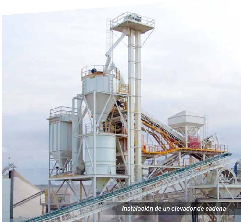
Instalación de un elevador de cadena
