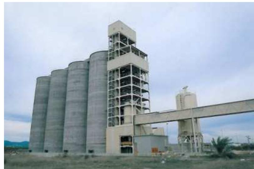
Silos de hormigón deslizado
